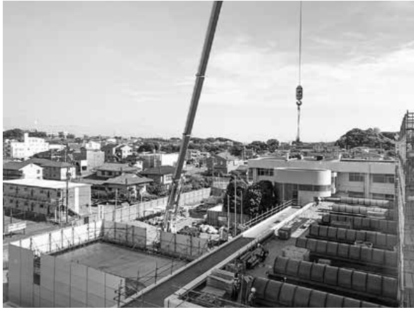
庁舎整備工事の様子
